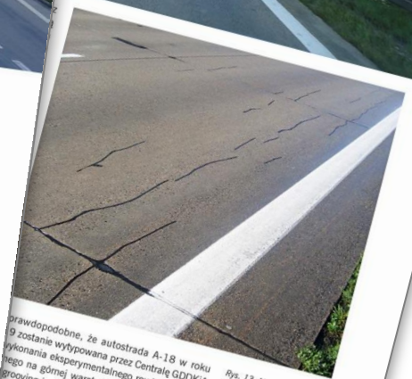
Rys. 13. Naprawione odcinki nawierzchni na jezdnii północnej autostrady A-18 (fotografia autora 2018 r.)
